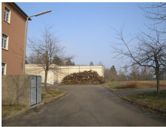
Abbildung 14: Sporthalle (Gebäude Nr. 8), 19.03.2016
