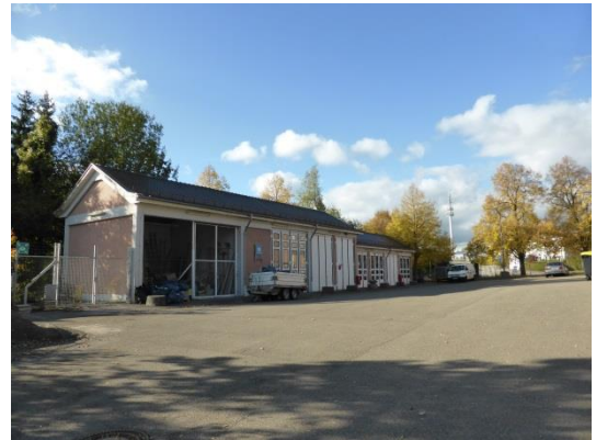
Abbildung 8: Garage (Gebäude Nr. 16), 07.10.2015
