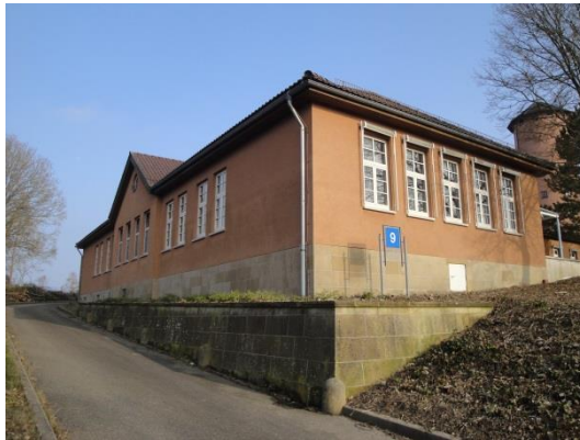
Abbildung 12: Unteroffiziersheim (Gebäude Nr. 9), 19.03.2016
