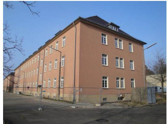
Abbildung 13: Mannschaftsheim (Gebäude Nr. 5), 19.03.2016
